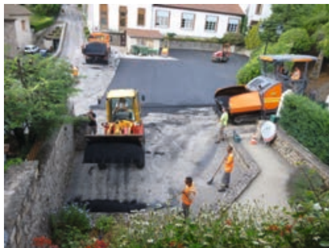
Goudronnage « place de la bascule »
